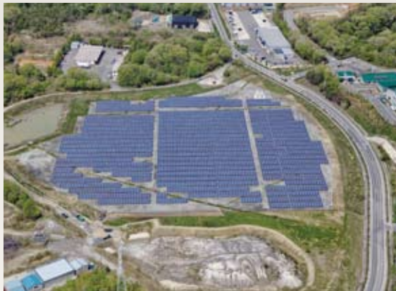
御船釜山跡地に、35,646㎡に及ぶ広大な「日本ルツボ 豊田ソーラーパーク」
