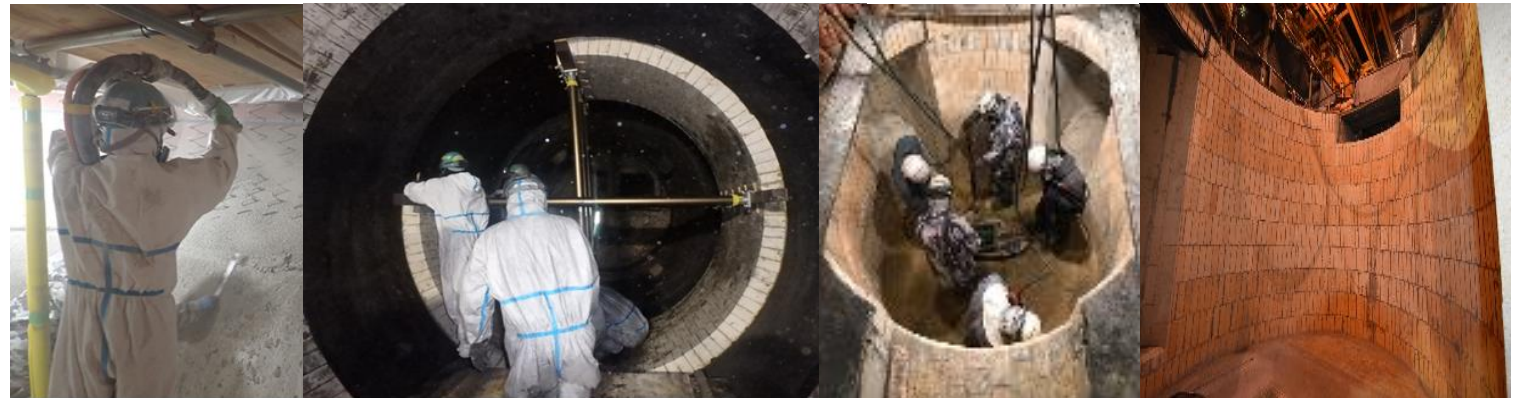
焼却炉／ロータリーキルン／溝形誘導炉工事施工例
