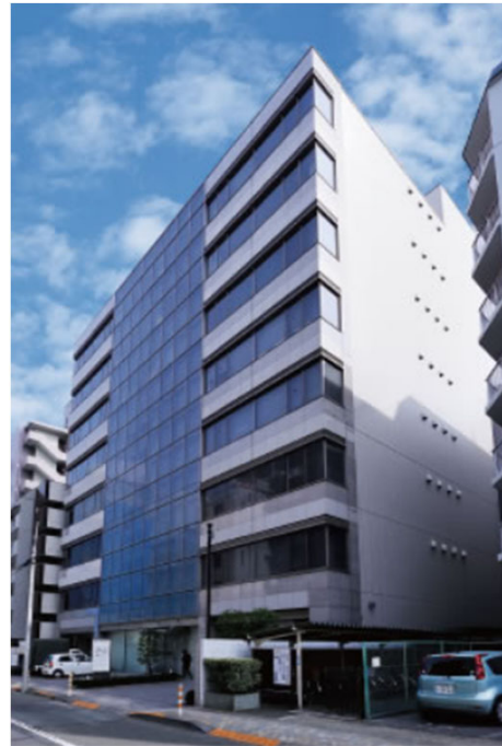
本社・オフィスビル
